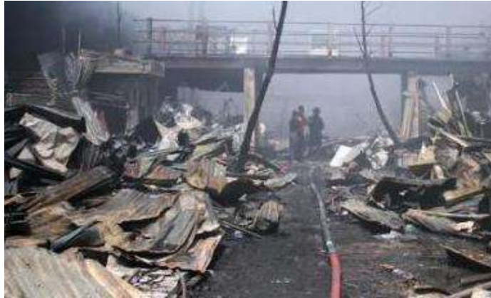
Gambar 3. Reruntuhan Bangunan Pasca kebakaran (Jateng.tribunnews.com)
