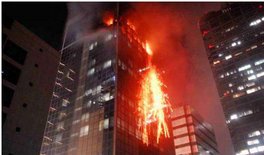
Gambar 4. Pecahan material kebakaran di suatu gedung ( http://poskotanews.com/2015/03/09/wisma-kosgoro-terbakar-hindari-jalan- )thamrin/)
