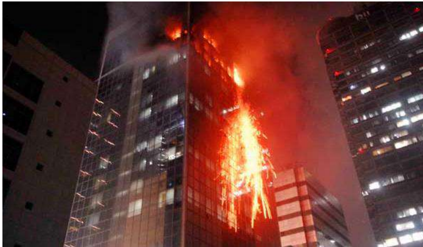
Gambar 50. pasca material kebakran gedung ( http://poskotanews.com/2015/03/09/wisma-kosgoro-terbakar-hindari-jalan- )thamrin/)
