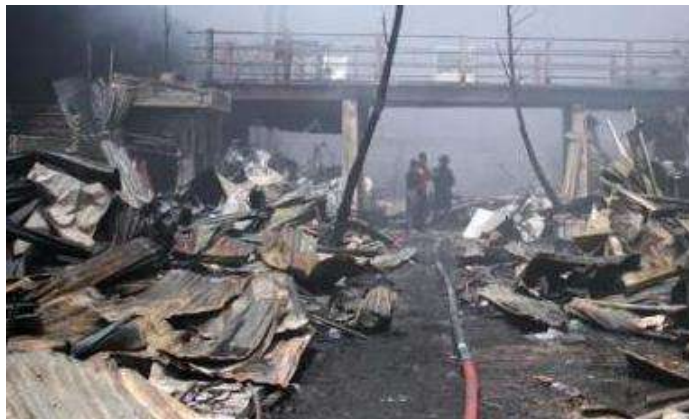
Gambar 49. reruntuhan bangunan pasca kebakaran (Jateng.tribunnews.com)
